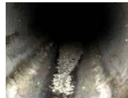
ディスポーザー設置地区の管渠内堆積物の状況
