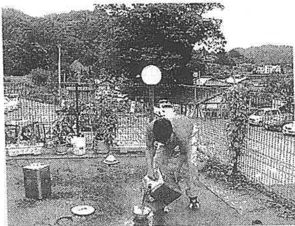
土中の分解菌を活性化させるために栄養剤を注入
